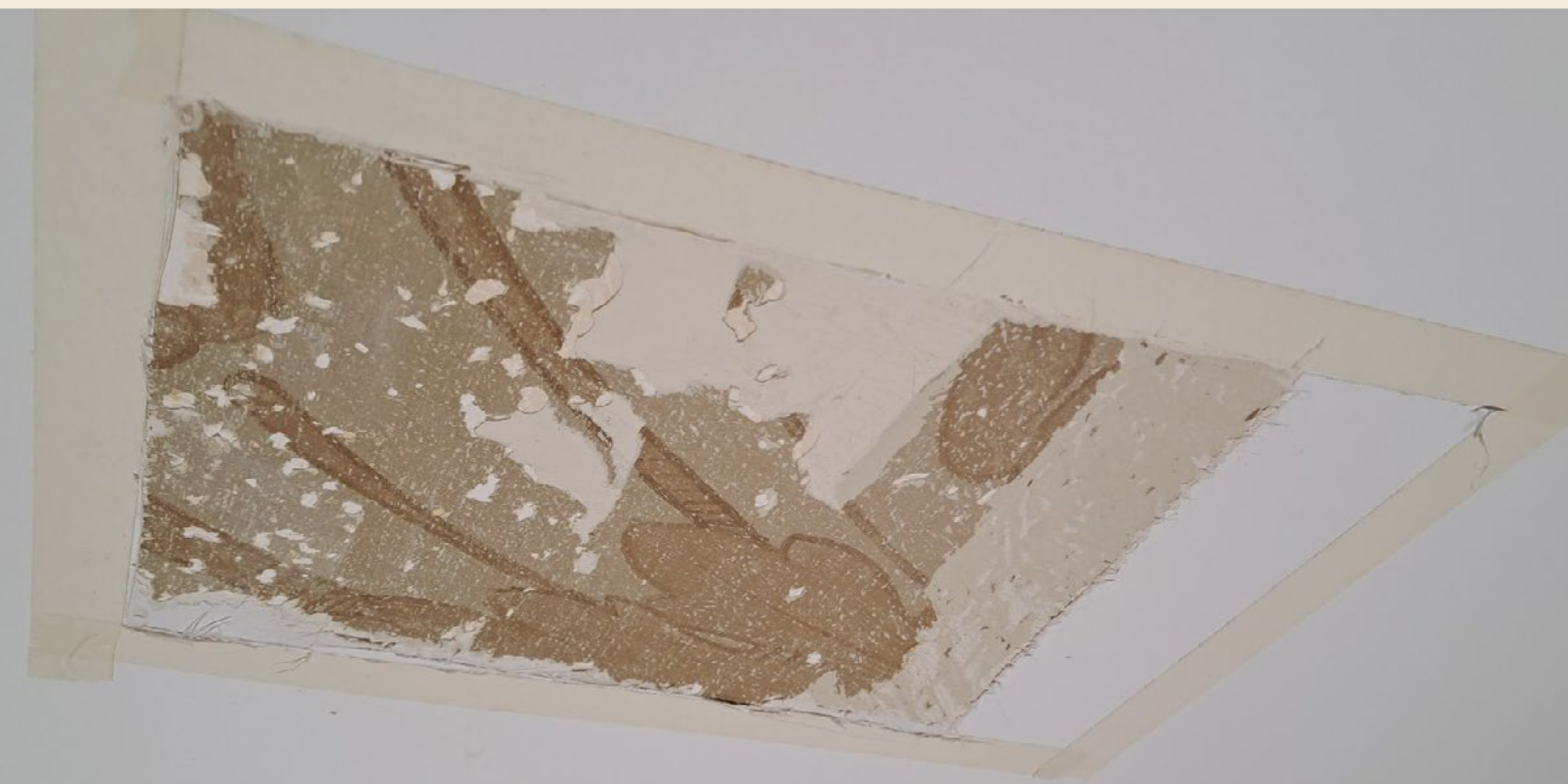
De originele plafondschildering van het Munten- en Penningenkabinet wordt teruggebracht
