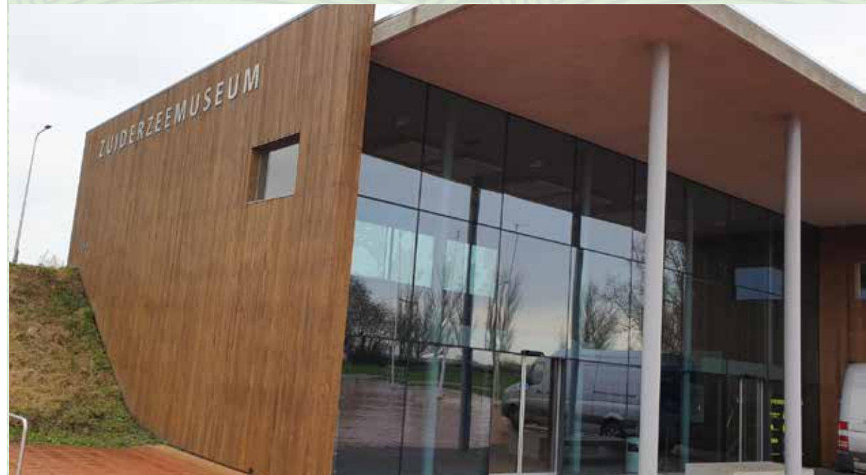
Groot onderhoud houten gevels Entree Paviljoen
