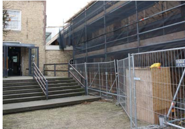
Renovatie pui Schepenhof
