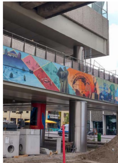
Zuidplein tijdens werkzaamheden
