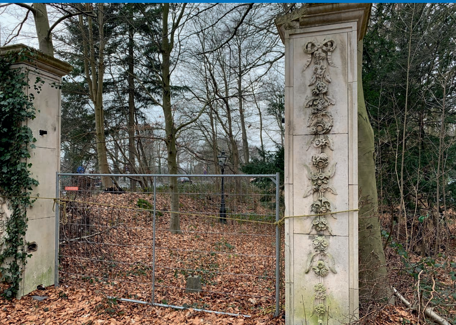
Afbeelding 6 Entree met hekpijlers van de van rijkswege beschermde historische buitenplaats Ivicke in Wassenaar. Van de verwaarlozing van deze buitenplaats is aangifte gedaan bij de politie. Parallel daaraan loopt een bestuursrechtelijk handhavingstraject.
