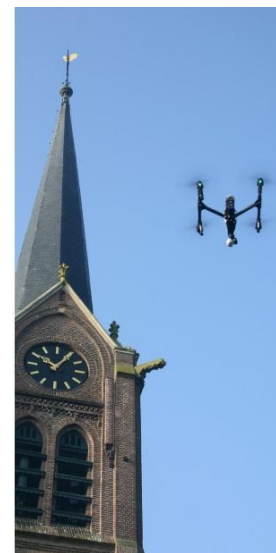
Inspectie door drones
