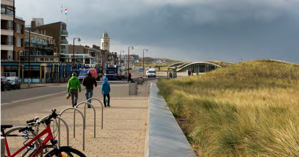
Dubbel ruimtegebruik: In de multifunctionele waterkering in Katwijk is een parkeergarage onder de boulevard gerealiseerd.
