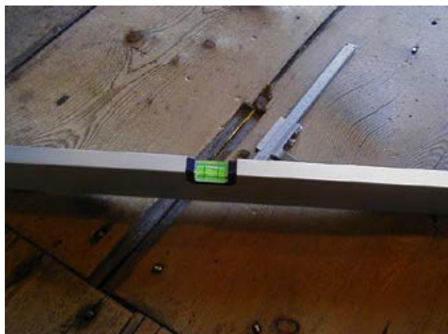
Figuur 32. Slijtage van vloerdelen boven aan een trap op het punt waar bezoekers de bocht nemen
