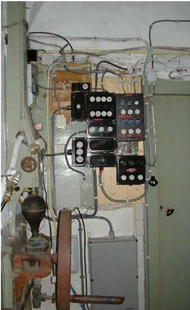
Figuur 57. Stoppenkast: bron voor een elektrische brand
