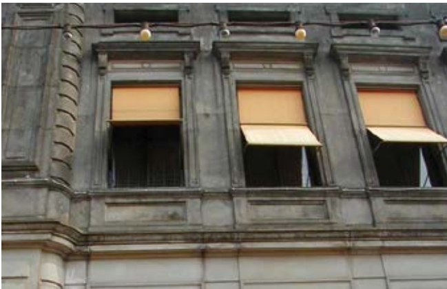
Figuur 87. Blokkeren op gebouwniveau: daglichtwering aan de buitengevel
