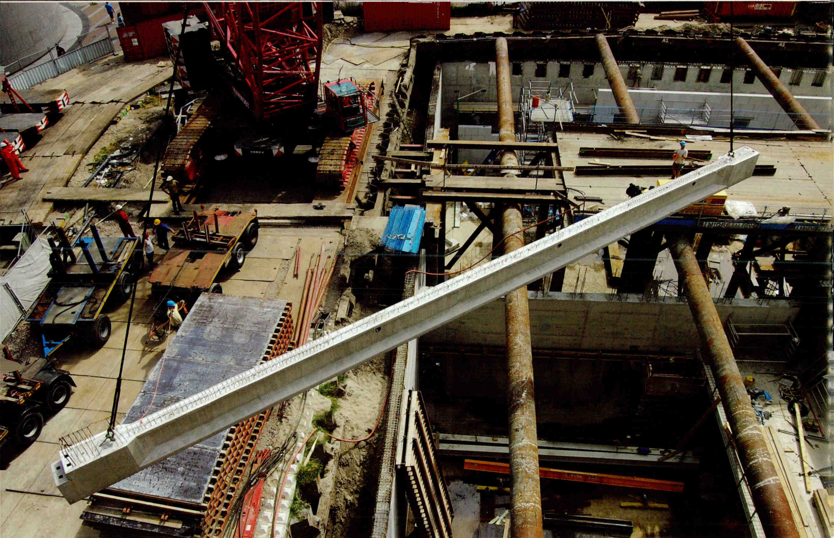
De monumentale trap bij de oude hoofdingang. rechts Doorzicht op kabinetten. beneden Een lange betonnen balk wordt geplaatst om het dak van de kelder, de vloer van het plein, te dragen. The majestic staircase near the former main entrance. right View through the galleries. below A long concrete beam is installed in the roof of the basement to support the floor of the square.
