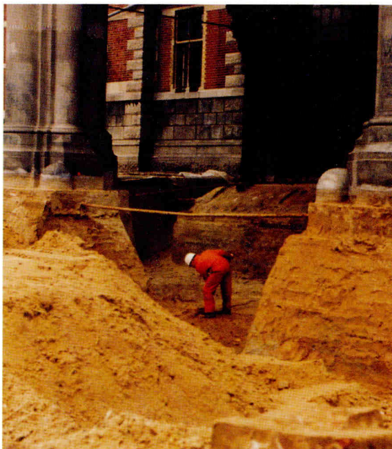
Werkzaamheden ten behoeve van het tunnelgebouw, af te ronden in 1998/1999
