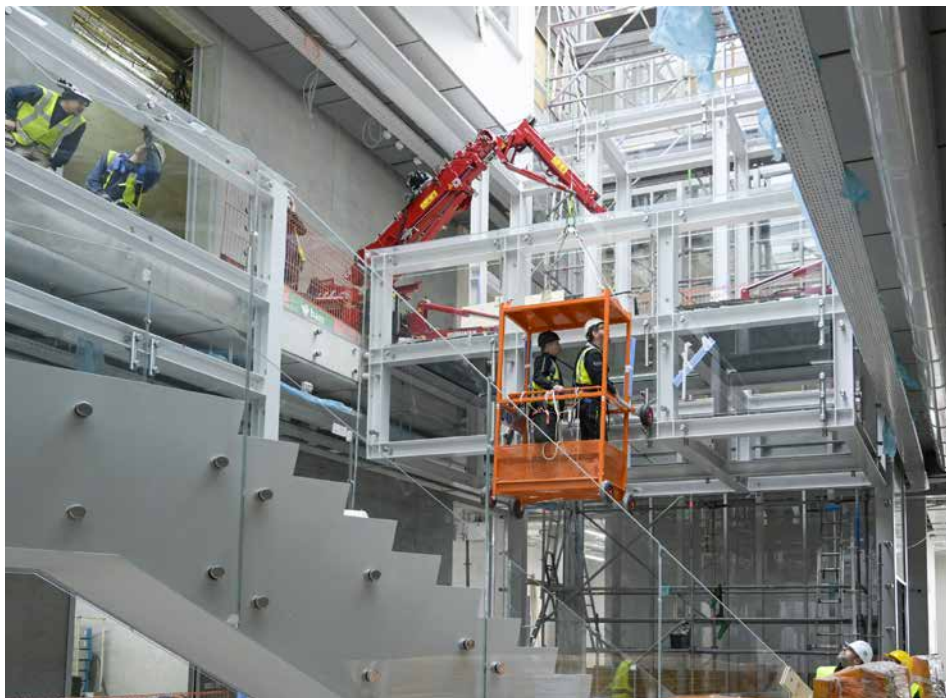
De atriumvitrines worden geïnstalleerd, foto Rob Glastra
