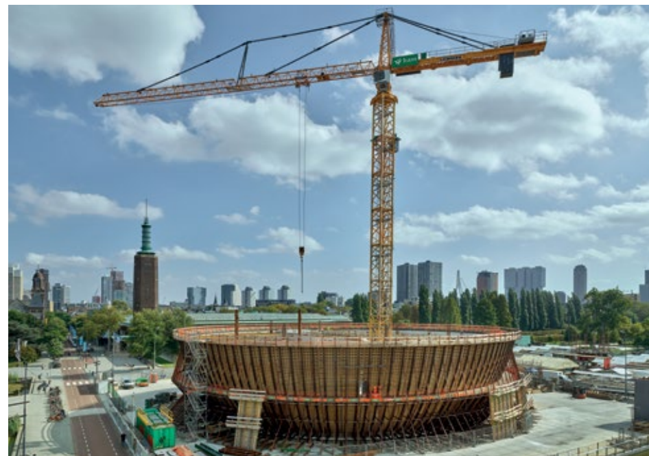
De bouw van Depot Boijmans Van Beuningen, september, foto Studio Hans Wilschut
