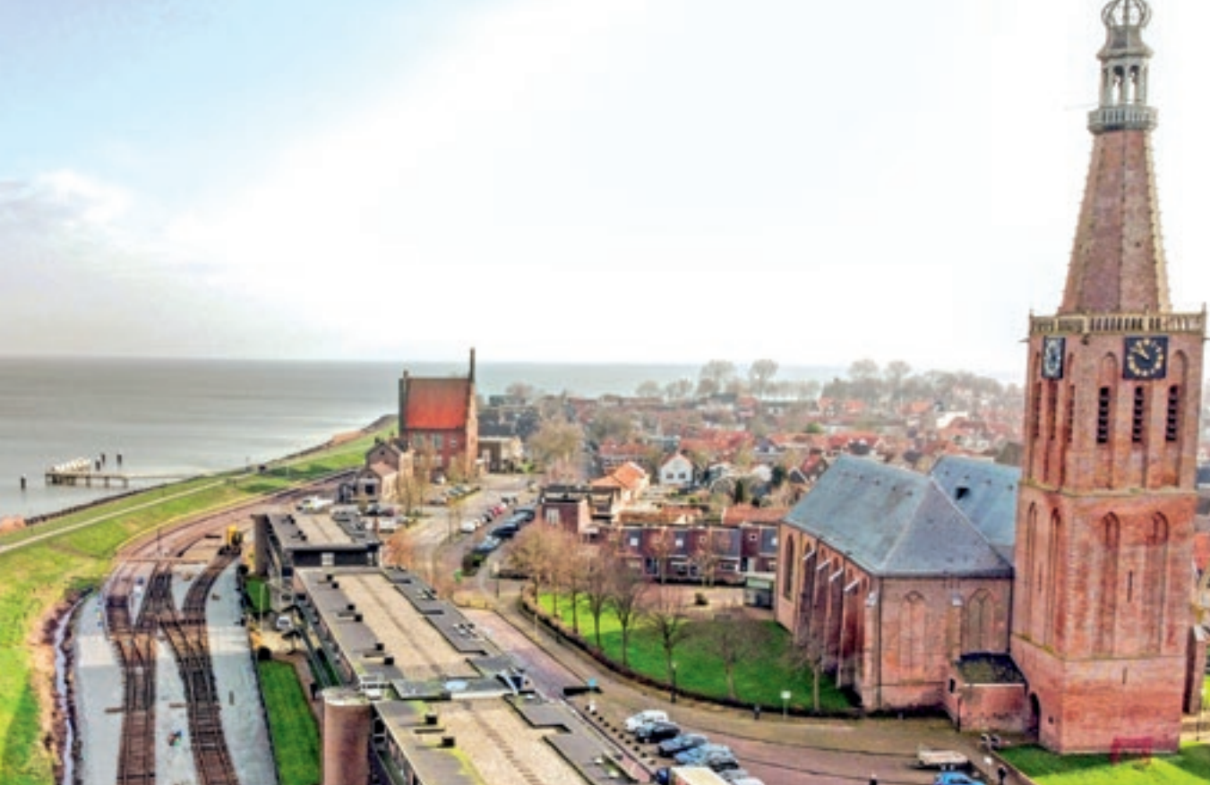
Museumstoomtram Hoorn-Medemblik heeft de bijdrage van de BankGiro Loterij aangewend om het spoor, de ondergrond en de inrichting van het historische station van Medemblik te restaureren en te reconstrueren.
