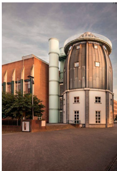
In 2020 bestaat het iconische gebouw van architect Aldo Rossi met daarin het Bonnefantenmuseum 25 jaar.
