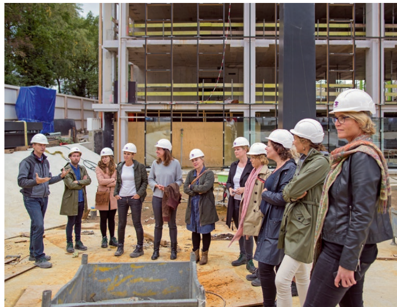
Loterijmedewerkers krijgen tijdens een 'Hard Hat Tour' een rondleiding door ons nieuwe huis in aanbouw.
