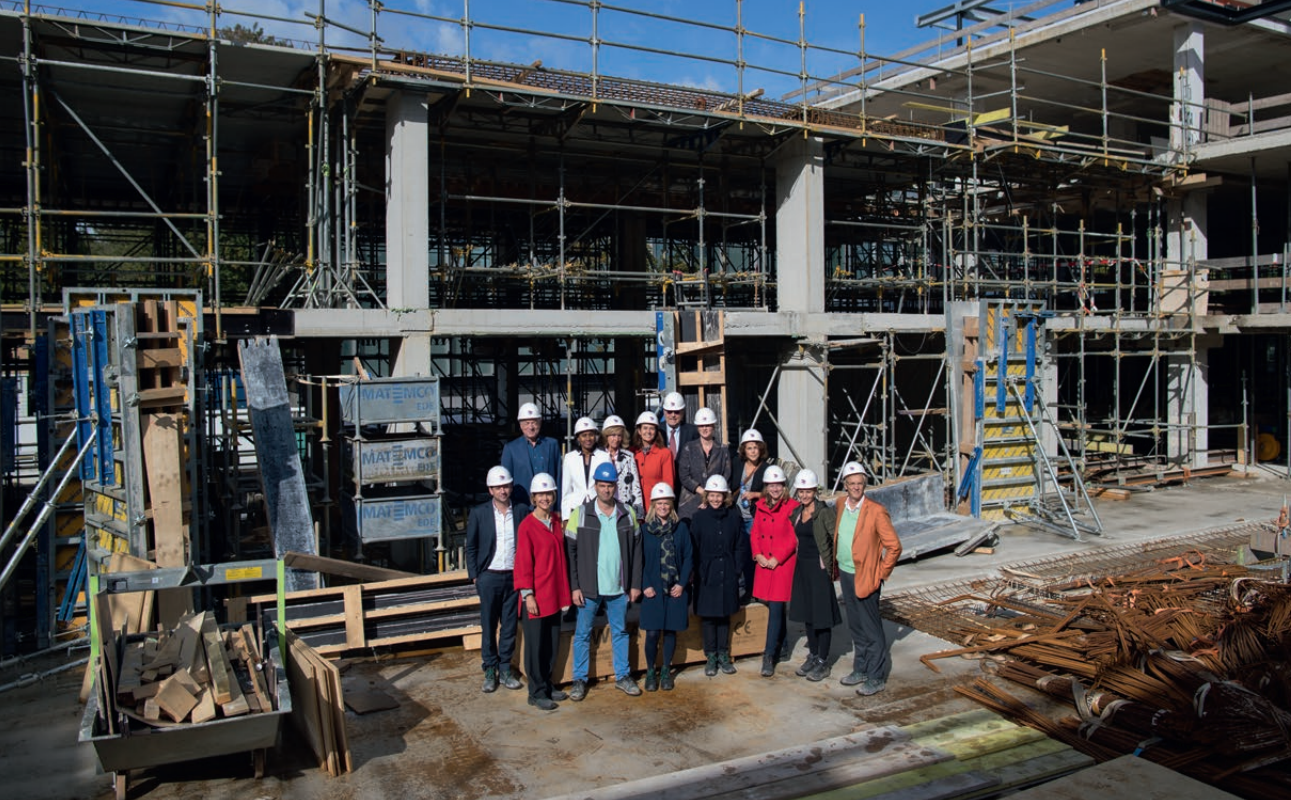
In september bezoeken de leden van de Raad van Commissarissen van Novamedia tijdens een 'Hard Hat Tour' de bouwplaats van het nieuwe duurzame huis van Novamedia en Goede Doelen Loterijen.
