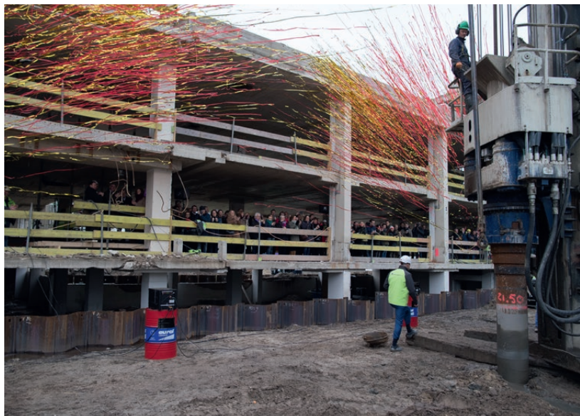
Op 31 januari 2017 zien zo'n honderd medewerkers van Goede Doelen Loterijen en genodigden hoe de eerste paal van het nieuwe kantoorpand wordt geslagen.
