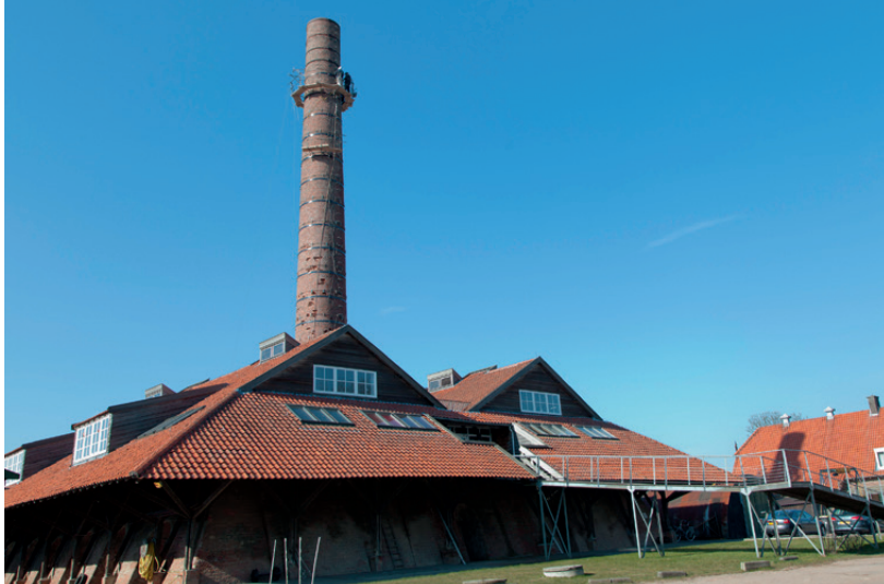
De schoorsteen van steenfabriek De Bovenste Polder in Wageningen heeft na restauratie zijn oorspronkelijke hoogte.
