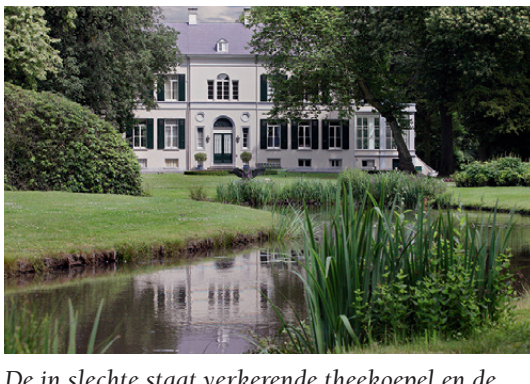
De in slechte staat verkerende theekepel en de daaronder gelegen ijskelder op landgoed Mattemburgh bij Roosendaal zijn onder handen genomen.
