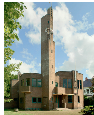
De vroegere commissiekamer in het Berlagehuis in Usquert (het voormalige raadhuis), is gerestaureerd, evenals de teruggevonden oorspronkelijke meubels.
