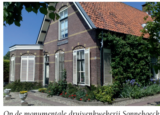
Op de monumentale druivenkwekerij Sonnehoeck in het Westland zijn de twee ketelhuizen met verwarmingsketels hersteld.
