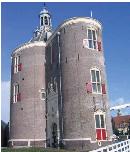
De voormalige stadspoort in Enkhuizen is nu Cultureel Centrum de Drommedaris.
