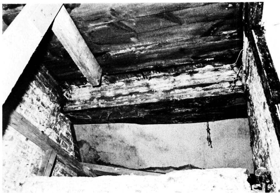
Het omstreden gangetje van binnen, verteerd door zwam en houtrot. Volgens de Rijksdienst bevinden de te vervangen onderdelen zich nog in technisch goede staat; de opdrachtgever wil deze onderdelen vervangen door herbouw van de oorspronkelijke stoep die voor de nieuwe functie van het gebouw niet kan worden gemist.
