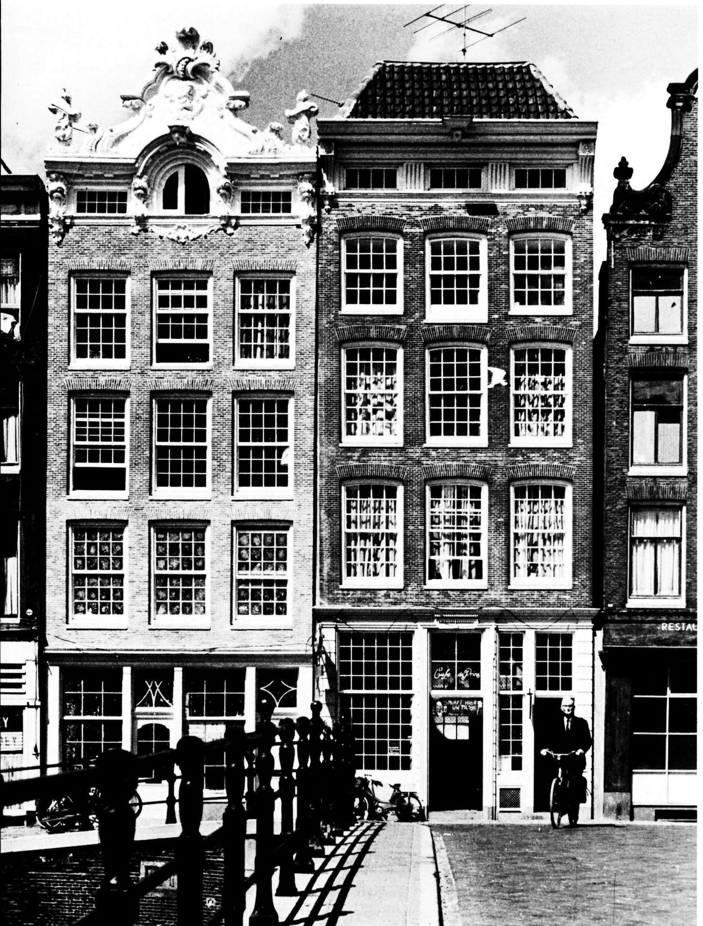
De panden Prinsengracht 124 (rechts) en 126 (links) waren zwaar verzakt, de gevels hadden T-ramen uit ca. 1890 en winkelpuien uit ca. 1930. Deze versleten 'sporen van de bouwgeschiedenis' zijn vervangen door een zorgvuldig gereconstrueerde 18de-eeuwse roedenverdeling die past bij de gevelbekroningen: een vreugde voor elke voorbijganger maar een steen des aanstoots voor de documentenzorgers.
