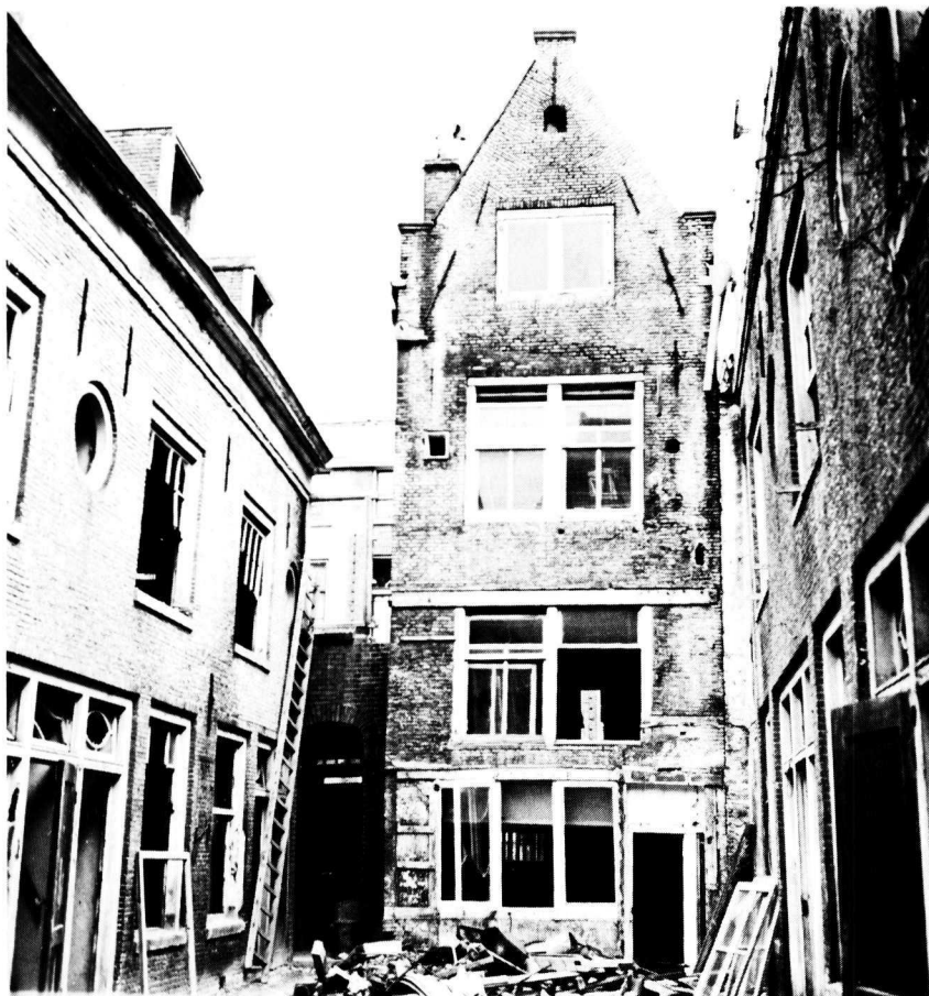
Binnenplaats van het v.m. Anslo's Hofje, thans Claes Claesz Hofje, met de achtergevel van het 17de-eeuwse pand Egelantiersstraat 52, in 1968, voordat de restauratie begon.
