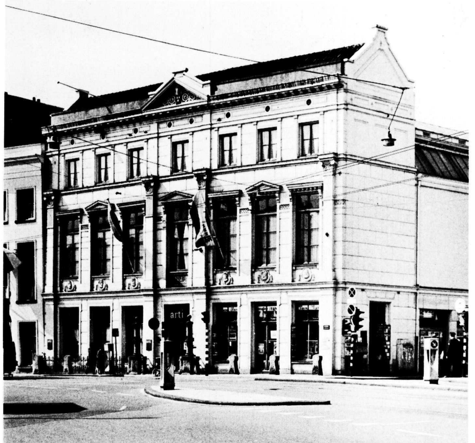
Arti et Amicitiae, op de hoek Spui-Rokin, in 1962-1964 van een dreigende ondergang gered. Ook hier werd 'teruggerestaureerd' door de ingang in de as van de voor-gevel te herstellen.
