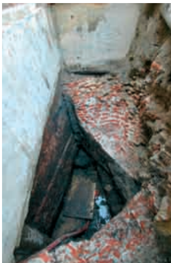
Een blik in de onderzoeksput aan de voet van de Metselaars-toren. De brede gemetselde hoek van oranje baksteen maakte onderdeel uit van de stadsmuur uit 1488.
