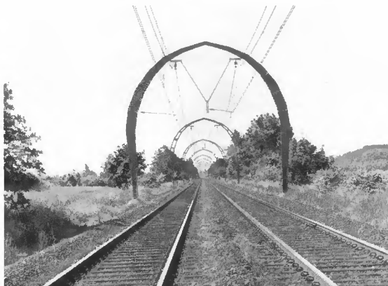
De unieke betonnen bovenleiding tussen Utrecht en Hilversum uit 1941. Een provinciaal monument?
