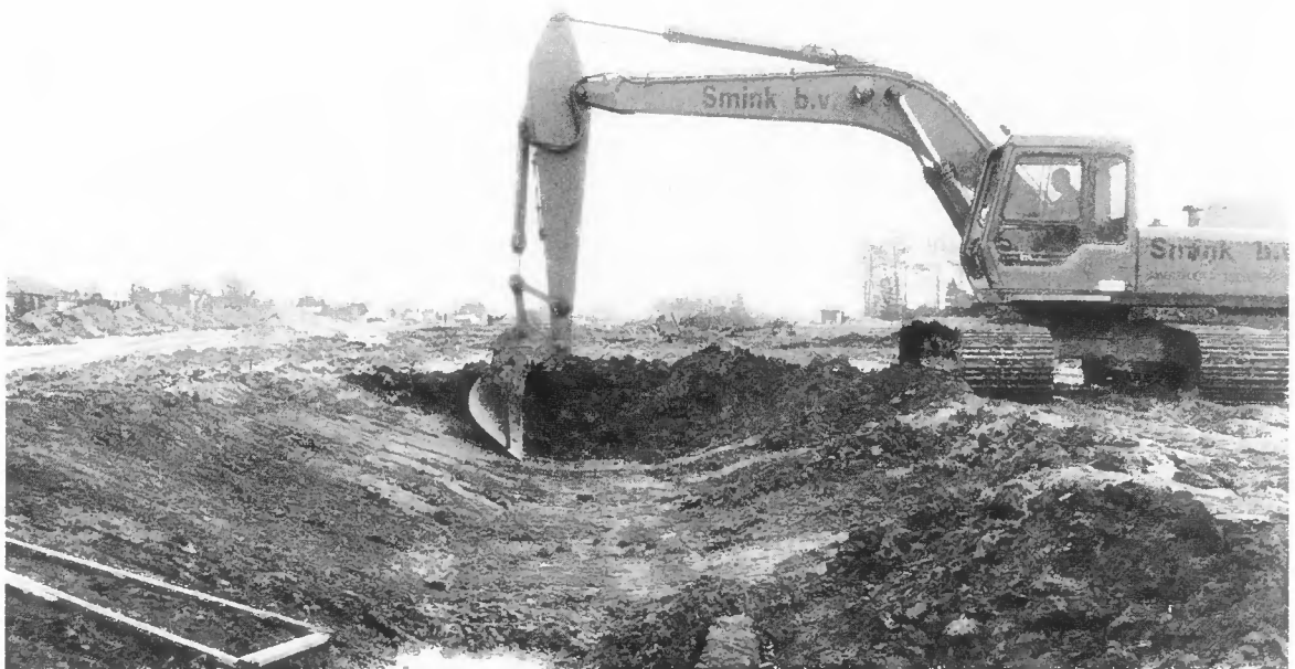
Reconstructie van de grachten van het kasteel De Lichtenberg in Woudenberg tijdens de aanleg van de rondweg rondom Woudenberg.
