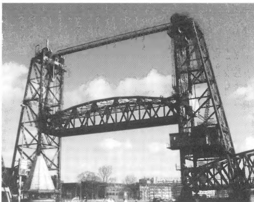
De spoorbrug 'De Hef'. (foto: M. Overbeek)
