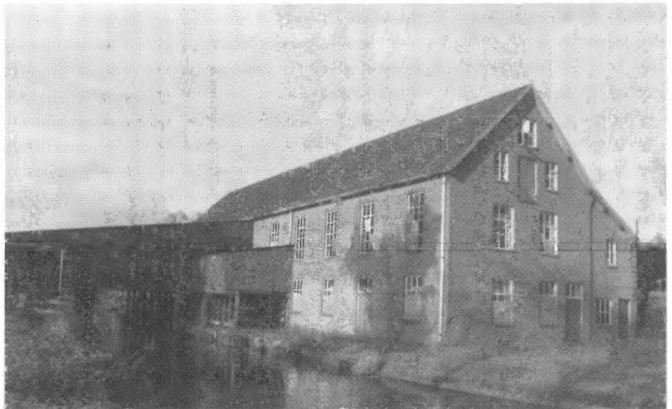
De Griendtsveen Turfstrooiselfabriek te Amsterdamscheveld (gem. Emmen) nu in gebruik bij het Industrieel Smalspoormuseum. (foto: provincie Drenthe)
