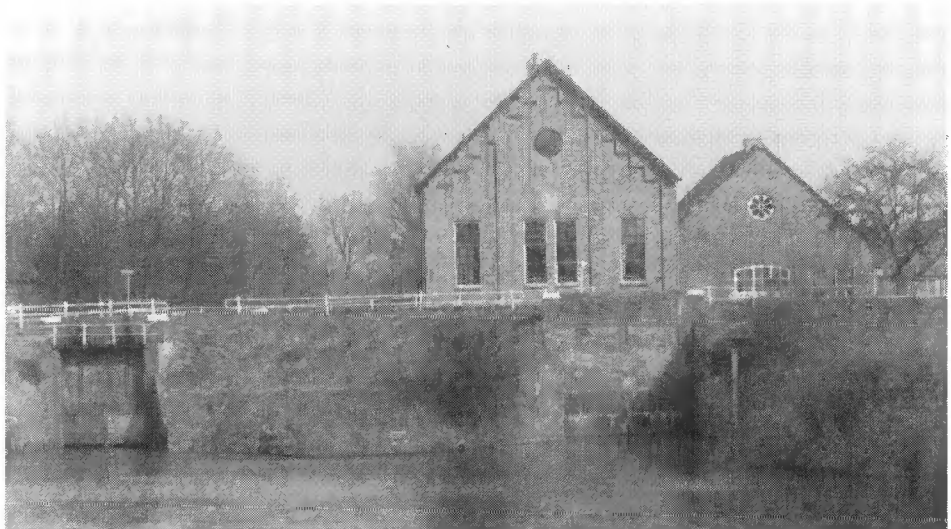
Het stoomgemaal te Appeltern, gebouwd in 1908.
