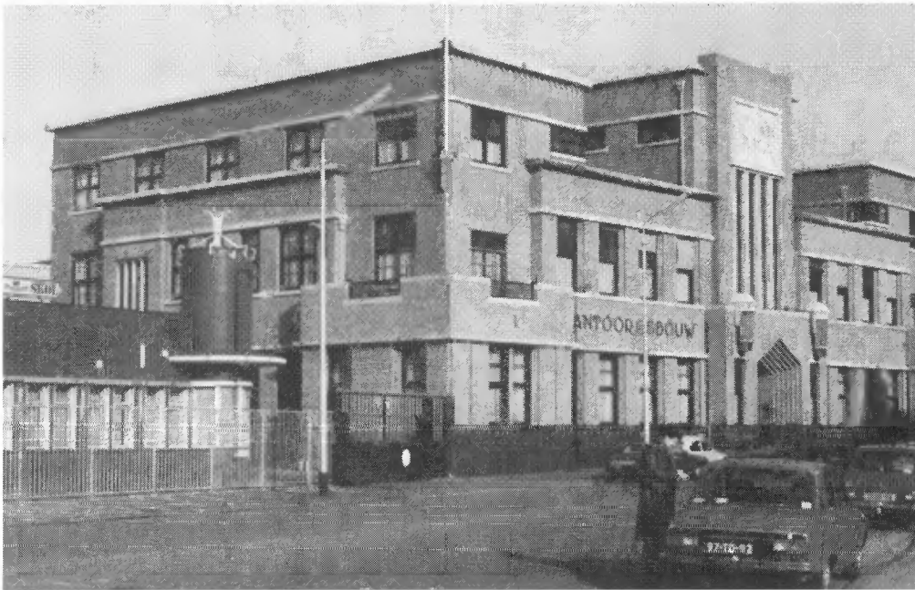
Voormalige Bierbrouwerij De Drie Hoefijzers te Breda; kantoorgebouw en brouwerij. (foto: ir. B.C. van Noordwijk)
