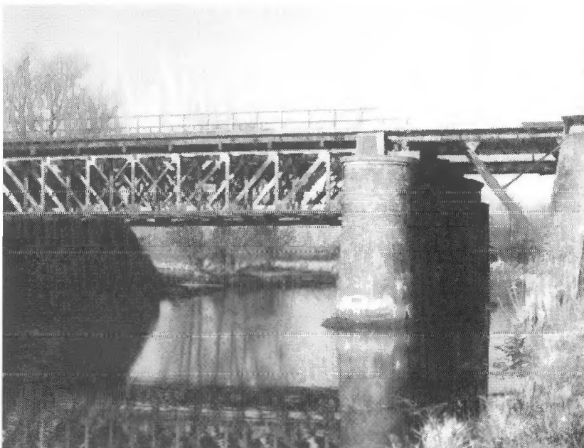
Kranespoorbrug in het fort aan de Diefdijk bij Leerdam. (foto: M. Overbeek)
