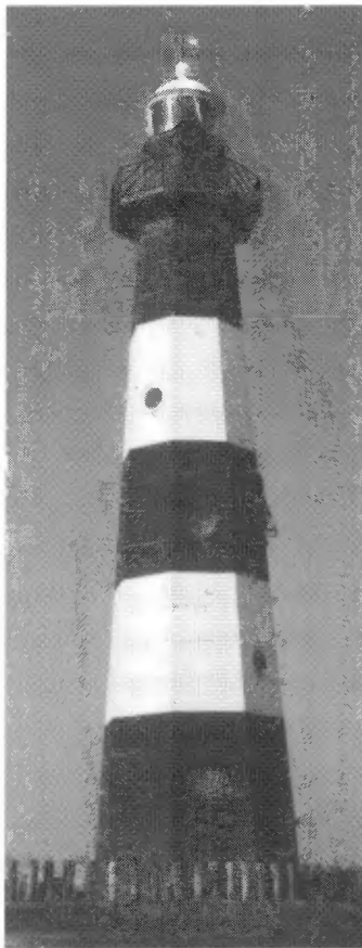
Vuurtoren van Breskens uit 1867; de oudste gietijzeren toren, die nog aan de Nederlandse kust staat. Ontwerp Q. Harder en vervaardigd door de ijzergieterij L.I. Enthoven te Den Haag. (foto: J.J. Havelaar)
