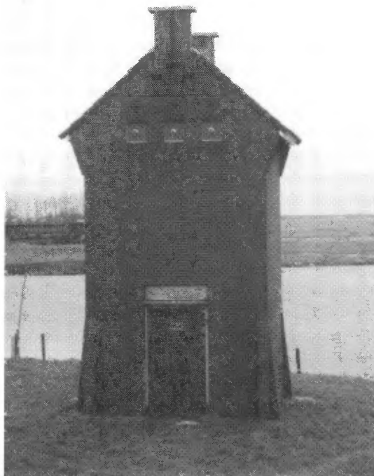
Trafohuisje aan de Eem, Eemdijk. (foto: M. Overbeek)
