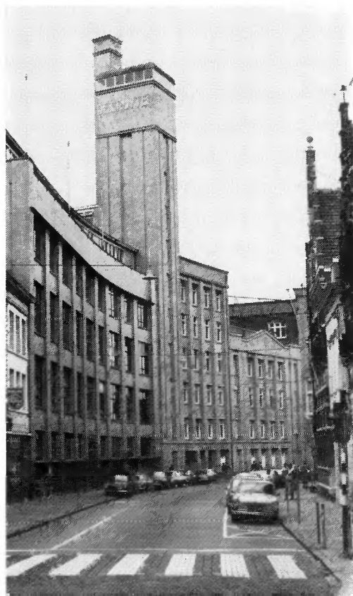
20. De Gruyter in de binnenstad van 's-Hertogenbosch: een verdwenen merknaam en fabriekscomplex.
