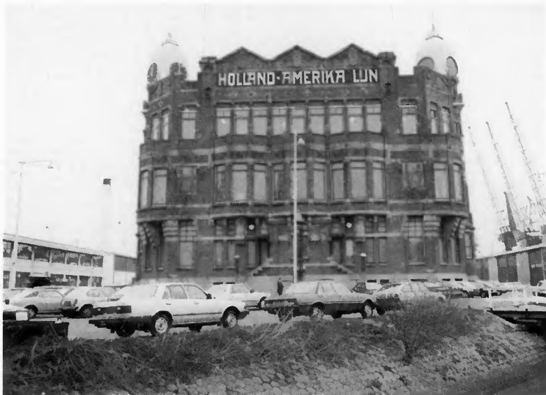
Rotterdam. Hoofdkantoor Holland-Amerikalijn aan de Wilhelminakade. Bouwjaar 1901. Architect: C.B. van der Tak. (Foto: Gem. archiefdienst Rotterdam)
