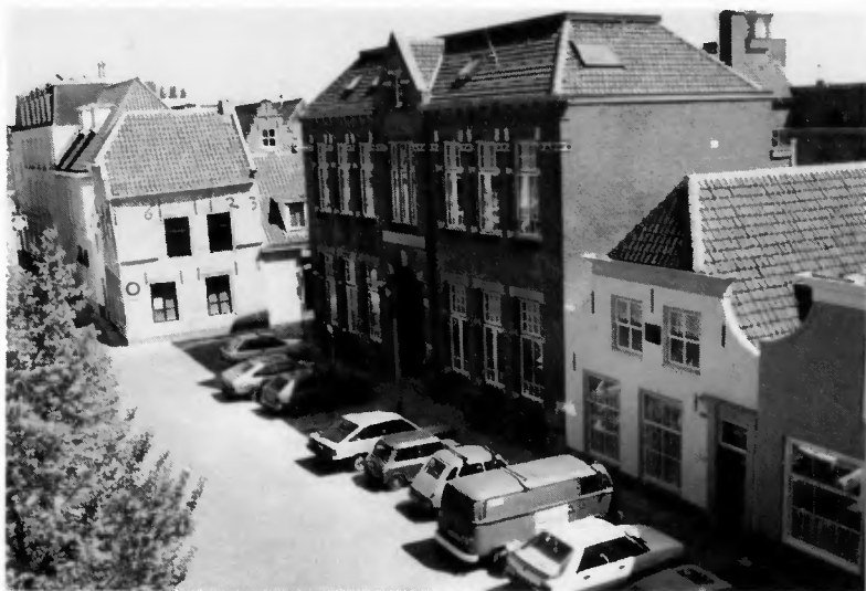
Goes. R.k. meisjesschool aan de Vlasmarkt met daarachter klooster en kapel. De panden zijn verbouwd tot 22 woningen en één kantoor. (Foto: Gem. fotodienst Goes)
