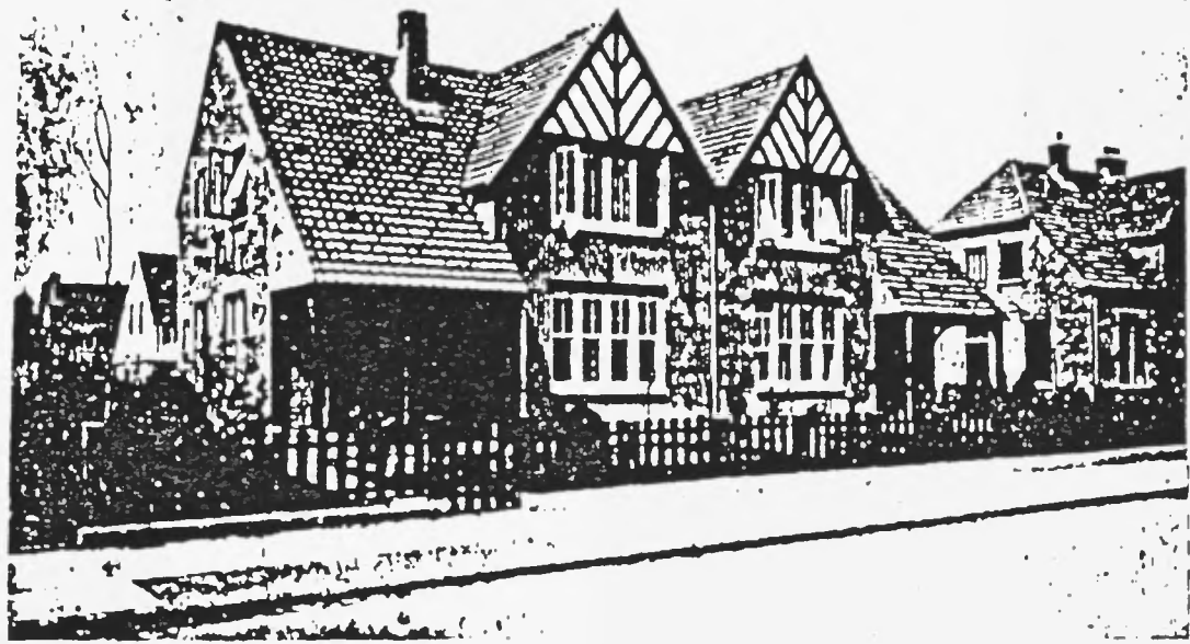
Fig. 201g. Ambtenaarswoning EE.
