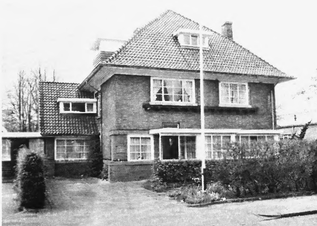
Dorpsstraat 1, woonhuis ontworpen door architect Co Brandes (1930)
