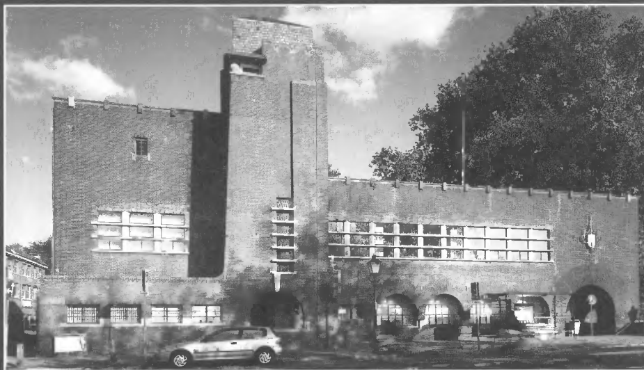
Politiebureau Tolsteegbrug te Utrecht, gerestaureerd door Van Hoogevest Bouw
